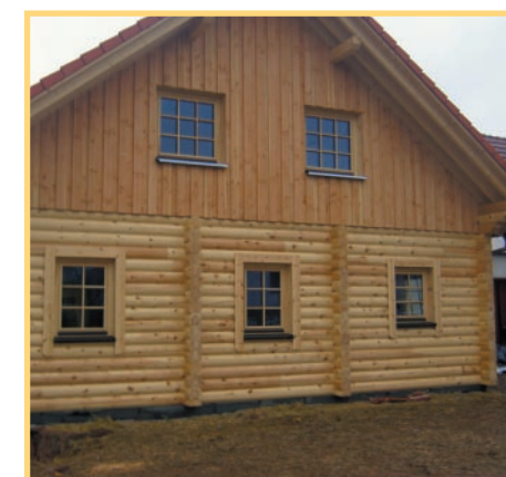
Dieses Rundholzhaus glänzte sogar mit einem n50-Wert von 1,0 h^{-1} .
