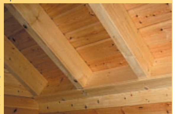
Die detailgenaue Ausführung lässt sich nur durch einen Luftdichtigkeitstest kontrollieren.
