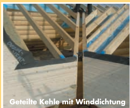
Diffusionsoffene Schalungsbahn
