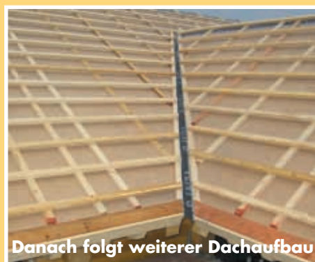
Anschlussfolien im Inneren
