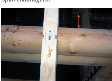
Stand der Technik: Eine Befestigung mit Langloch ist optisch ansprechend. Dies gilt besonders bei sichtbaren Sparren.
