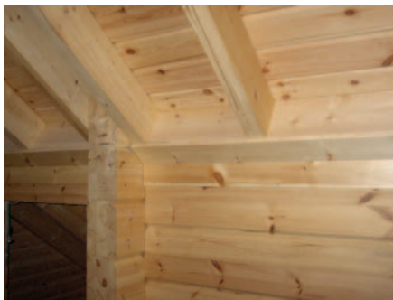
Bild 4: Der fertige verkleidete Traufwandanschluss
