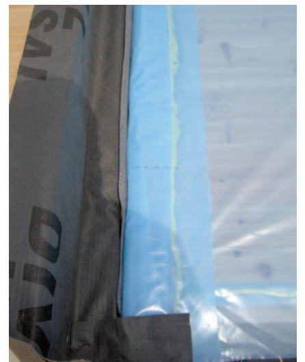
Bild 10: Die durchgehende Verklebung ist zwingend notwendig
