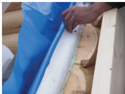
Bild 8: Lieber ein bisschen mehr als zu wenig Klebematerial aufbringen.
