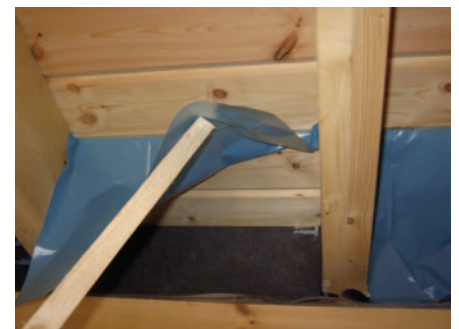
Bild 2: Schon beim Rohbau muss an die Luftdichtigkeit gedacht werden
