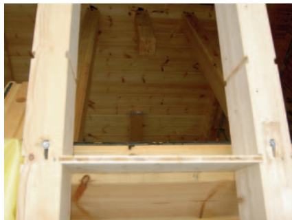
Bild 1: Eingefräste Stellbretter innen und außen
