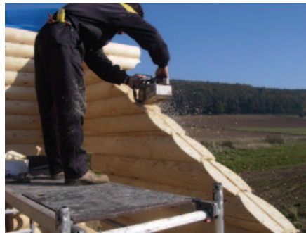
Bild 6: Ein tiefer Schlitz ist aufwendig, aber unbedingt notwendig
