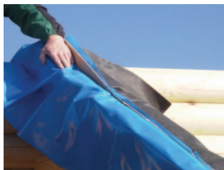
Bild 7: ein Hartfaserstreifen wird eingebaut
