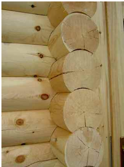
Bild 4: erst nach dem Trockenriss sitzt die Bohle optimal
