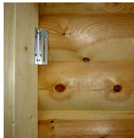
Bild 7: Anschluss mit Langlochblech
