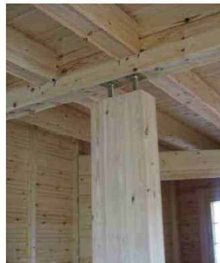
Bild 6: Doppelter Schraubfuß oben, zur erhöhten Lastaufnahme geeignet
