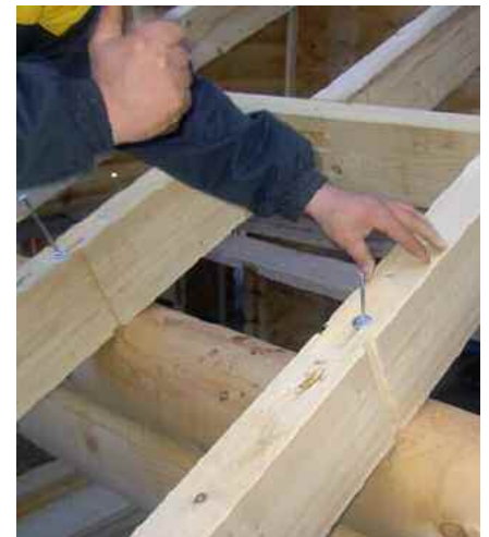
Bild 8: Langloch im Sparren zur Aufnahmen des Sparrennagels, hier mit eingefrästen Stellbrettern.
