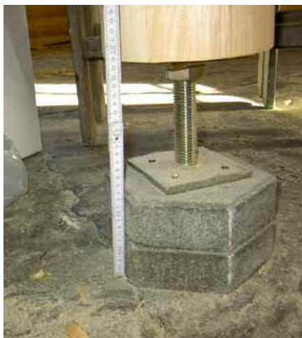
Bild 5: Schraubfuß unten, vorbereitet für Estricheinbau
