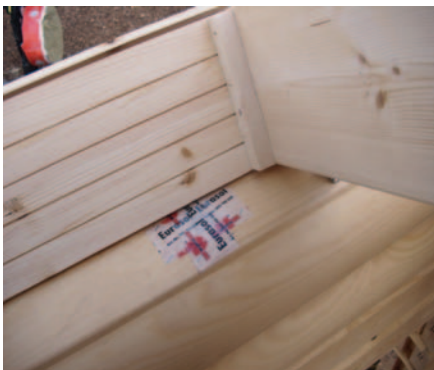
Bild 2: Auch oben muss die Elektrolochbohrung verschlossen werden.
