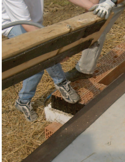
Bild 3: Dichtband unter der Ersten Blockbohle
