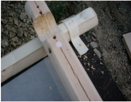
Bild 1: Verschließen der Elektrobohrungen mit eingeleimten Holzstopfen
