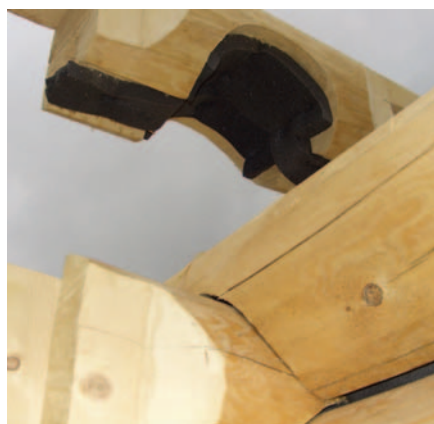
Bild 9: Dichtband bei Naturstamm
