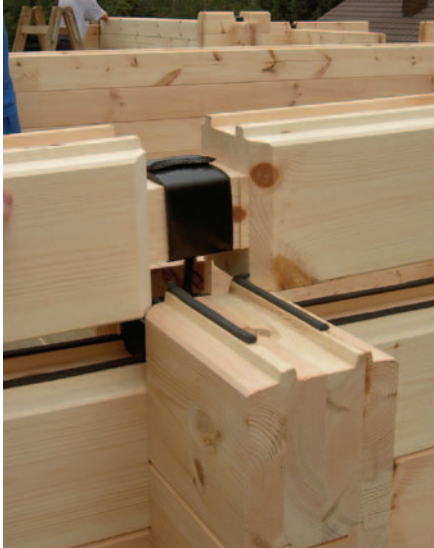
Bild 6: Dichtband bei Kantholz
