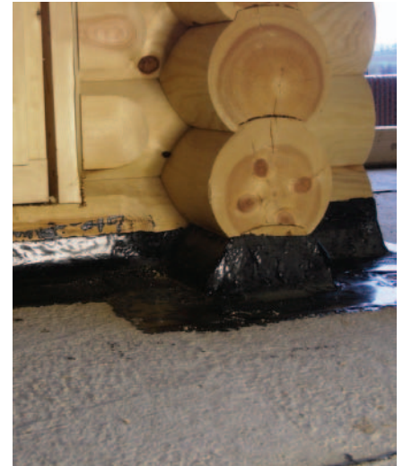
Bild 4: Schweißbahnverklebung des Sockelpunktes
