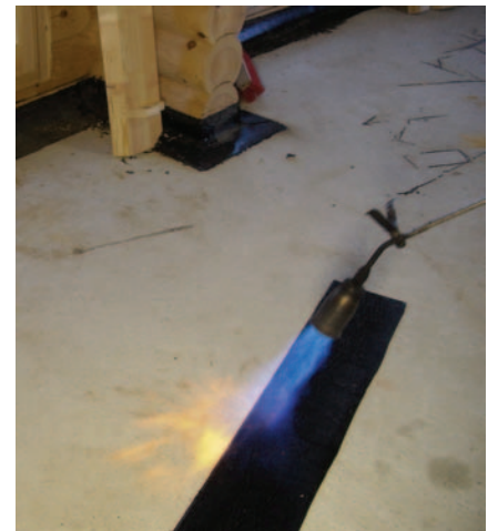
Bild 5: Erhitzen der Schweißbahn mit Abstand zur Blockbohle.
