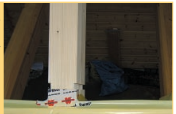
Die Anbindungen zwischen Stellbrettern und Sparren sind sauber zu verkleben.
