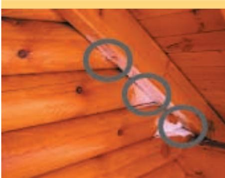
**Bild 2:** Durch die Undichtigkeit kommt es zur gefrierenden Kondensation.
