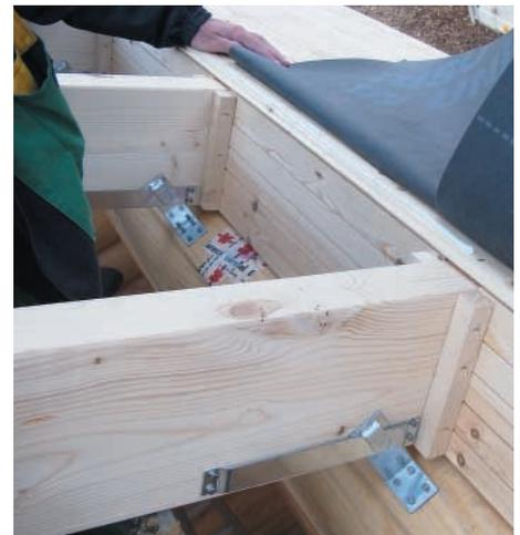
**Bild 1:** Das Stellbrett befindet sich zwischen den Sparren.
