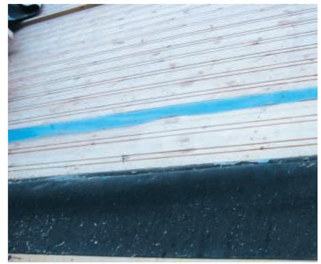
**Bild 6:** Die Folie muss außen noch mit der Dampfsperre präzise verklebt werden.
