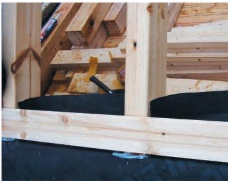
**Bild 4:** Jetzt wird über der Außenwand geschalt und die dampfdichte Folie eingezogen.
