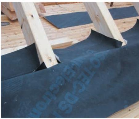
**Bild 2:** Im ersten Arbeitsgang wird die diffusionsoffene Folie aufgelegt.
