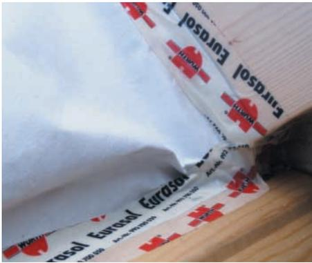
**Bild 3:** Die diffusionsoffene Folie muss genau und winddicht angeklebt werden.
