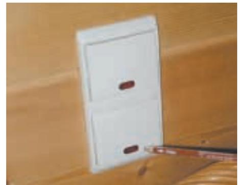
*Der Schalter wurde nicht mittig auf den Blockbalken ausgerichtet und zudem nicht abgedichtet.*
