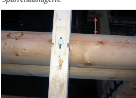
Stand der Technik: Eine Befestigung mit Langloch ist optisch ansprechend. Dies gilt besonders bei sichtbaren Sparren.
