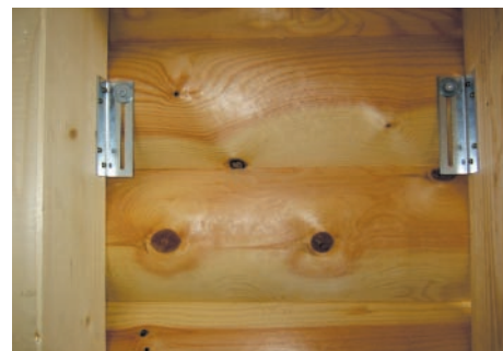
Die vertikalen Langlochwinkel erlauben eine bewegliche Balkenbefestigung und somit die zuvor bestimmte Setzung.
