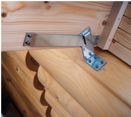
Gleitisen gehören zu den häufig verwendeten Befestigungen bei gleitenden Sparrenauflagern.
