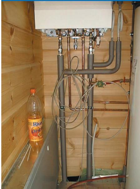
*Die Zuleitungen zur Gastherme führen geradewegs aufwärts, die Verlegung in einer Schleife wäre erforderlich.*
