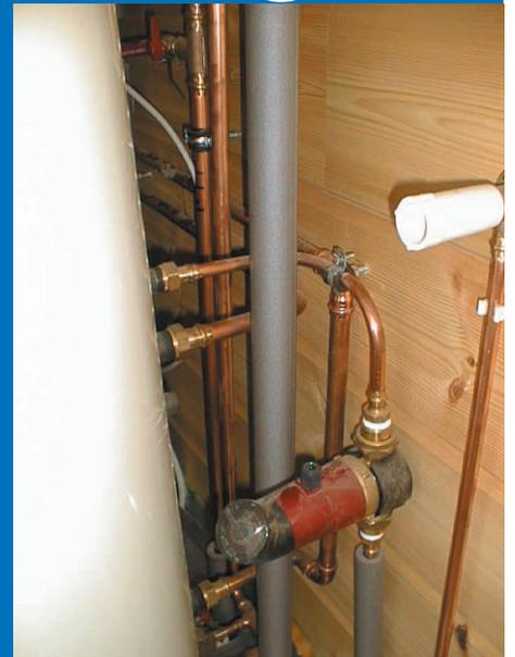
*Die Fixierung der Wasserleitung mit einer Schraubenschelle wird bei einer starken Setzung des Blockhauses abreißen.*
