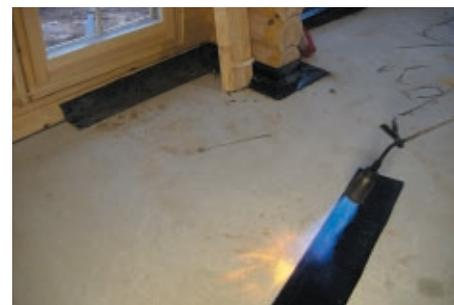
*Tip: Die Verklebung der unteren Blockbohle an der Bodenplatte sollte vor dem Einbringen der Installationen durchgeführt werden.*
