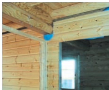
Ständerwand mit Paneelverkleidung unter einem Unterzug
